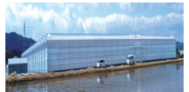
実証研究施設全体の外観
